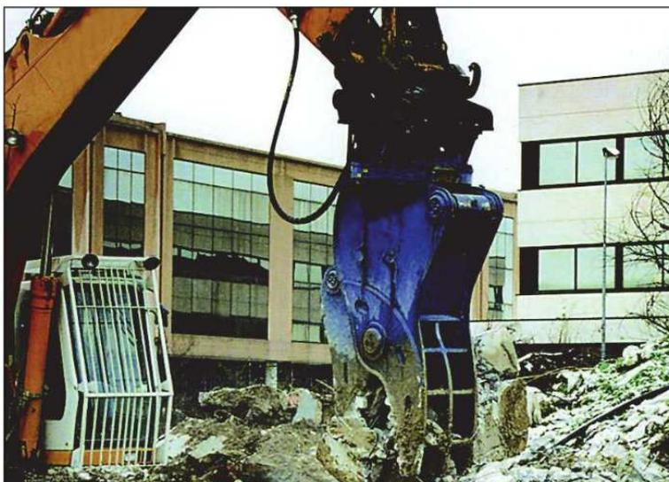
FOTO DI UN ESCAVATORE CON PINZA DEMOLITRICE
